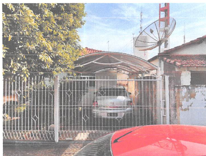
Fotografia 2 – Entrada da garagem
