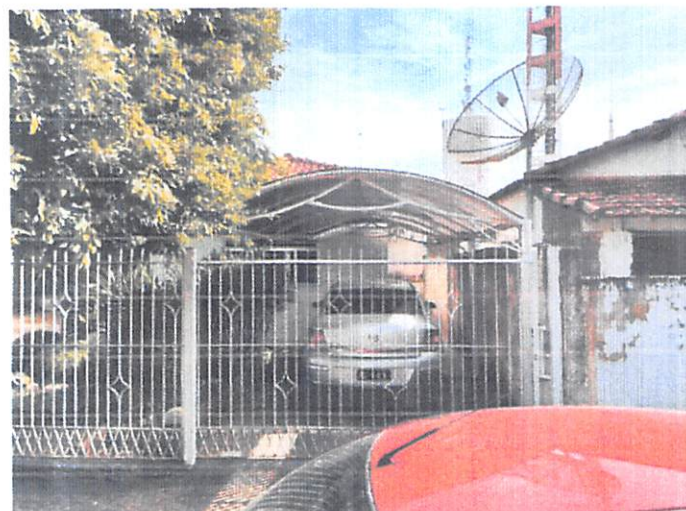
Fotografia 2 – Entrada da garagem
